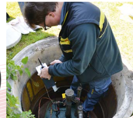
Le technicien de service raccorde la sonde de mesure à l'unité de calcul et de communication.
