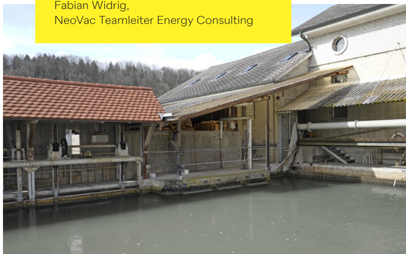
Das hauseigene Wasserkraftwerk produziert jährlich rund 1'700 Megawattstunden.
