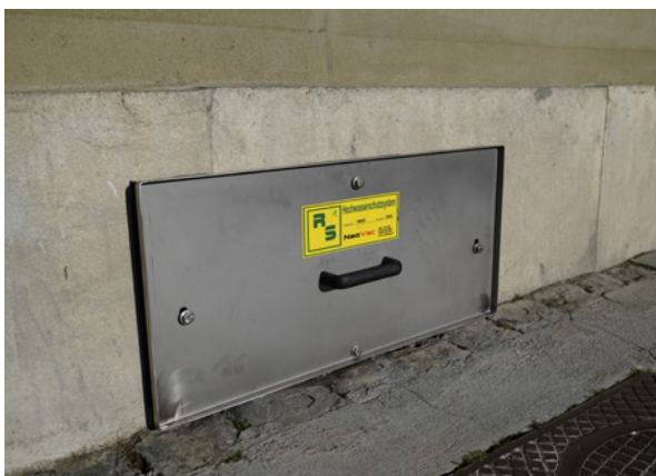
Insgesamt 16 Fensterstotts sorgen nun für Schutz vor Hochwasser.
