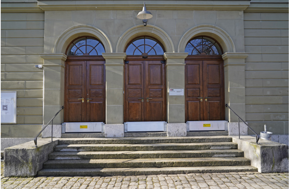
Die Volksschule Matte in Bern ist durch das NeoVac Hochwasserschutzsystem für den Notfall gerüstet.
