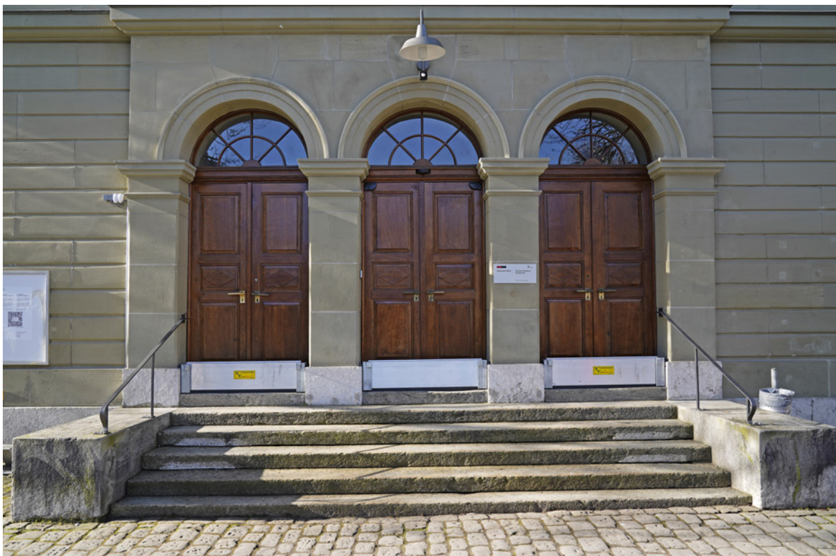
La scuola elementare di Matte a Berna è pronta per le emergenze con il sistema di protezione dalle piene NeoVac.
