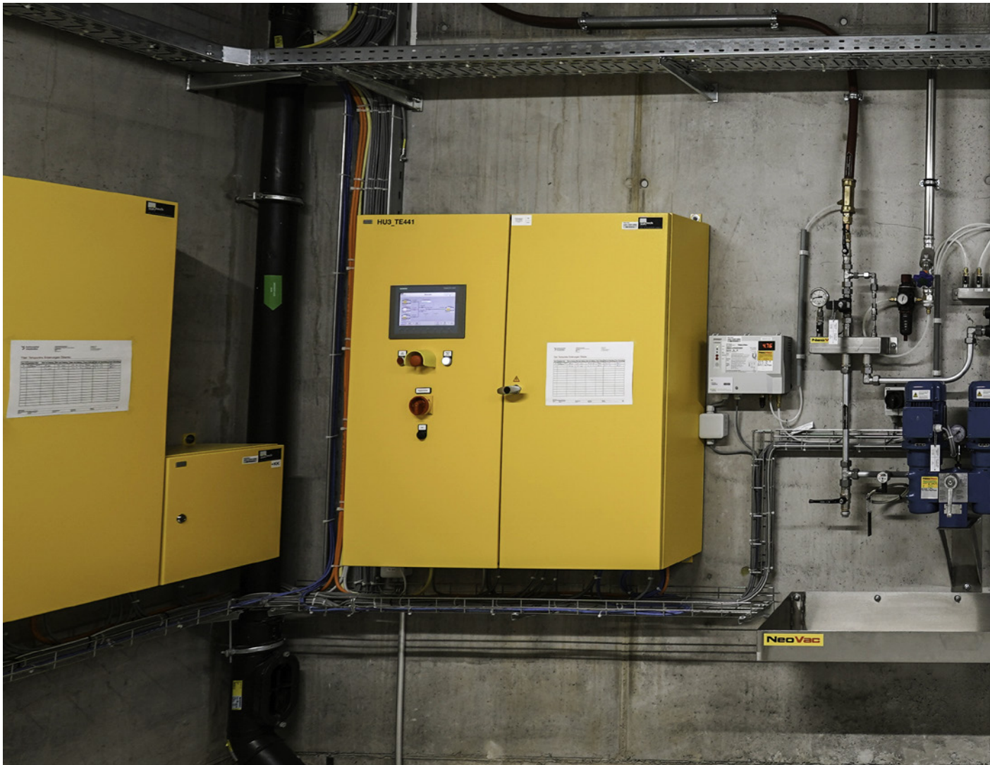
L'impianto per l'approvvigionamento di combustibile ha una progettazione ridondante. Entrambi i sistemi funzionano in modo indipendente l'uno dall'altro: in caso di guasto di un impianto, il sistema passa automaticamente all'altro.
