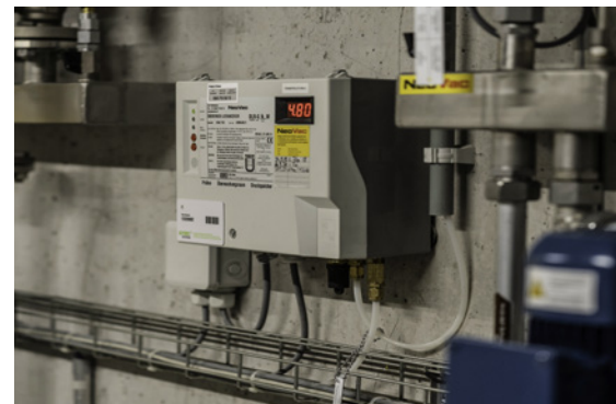
Il dispositivo di monitoraggio della linea mostra la pressione nel tubo intermedio.
