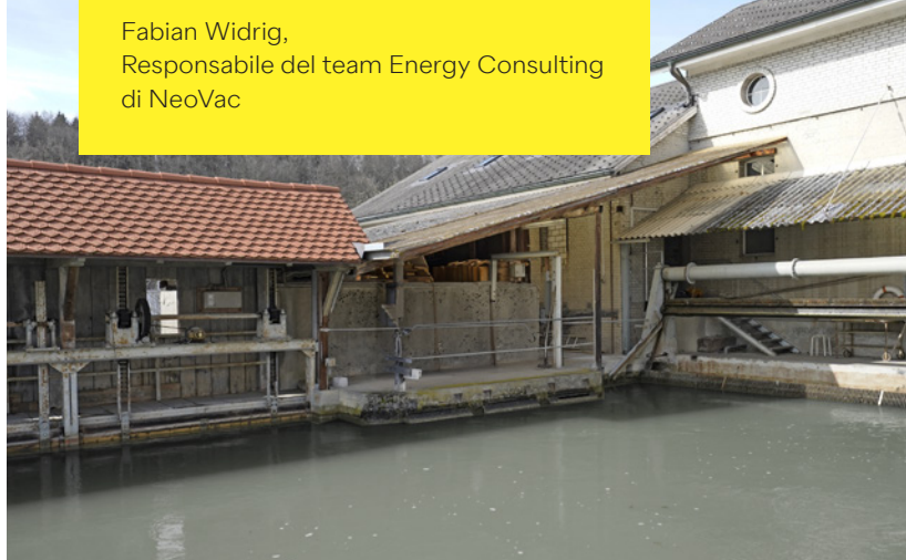
La centrale idroelettrica interna produce circa 1'700 megawattora all'anno.
