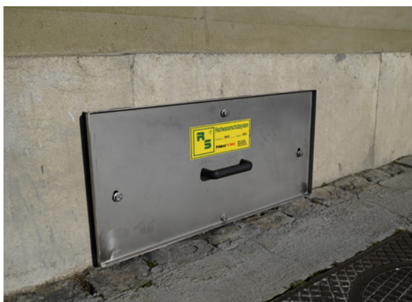
16 paratie per finestre in totale forniscono protezione dalle piene.
