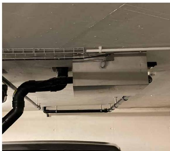
Nel garage sotterraneo è visibile la condotta di scarico con la linea di scarico intermedia.
