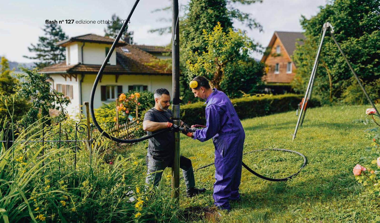
Preparazione del tubo di infissione con cui verrà creato un buco nel terreno, in cui verrà inserito il nuovo anodo. La tecnica permette di evitare lavori di scavo di grandi dimensioni in quanto non richiede ampie aperture a terra.
