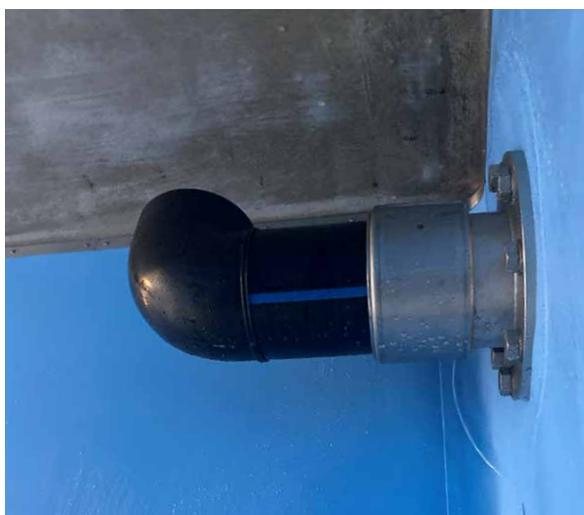
È stato installato un nuovo troppo pieno con adeguata guarnizione flangiata per garantire l'impermeabilità del serbatoio d'acqua potabile
