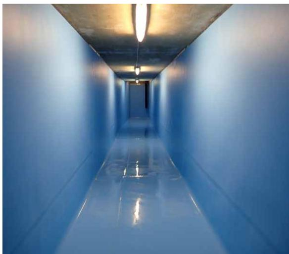
Nello stretto passaggio attraverso il serbatoio dell'acqua risanato si notano i lavori di ammodernamento. Il serbatoio ha una capacità di 50 m<sup>3</sup>.
