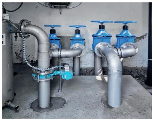
Conduite d'arrivée de source dans l'installation UV
