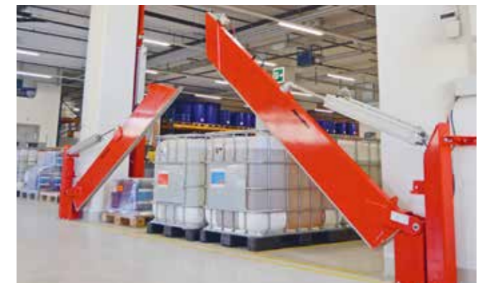
Des barrières de retenue d'eau d'extinction d'incendie avec déverrouillage automatique et réinitialisation
