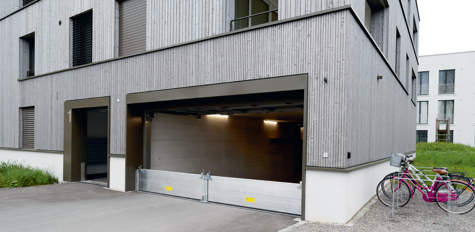
Systèmes de protection contre les inondations
