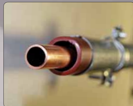
Sistema NeoWatch con condotto del prodotto in rame per il trasporto di oli minerali Impiego < 8 bar
