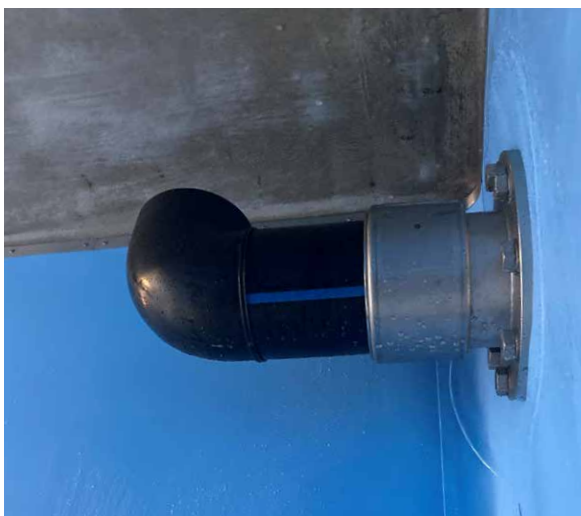
Neu installierter Überlauf mit angepasster Klemmflanschabdichtung zur Sicherstellung der Wasserdichtigkeit
